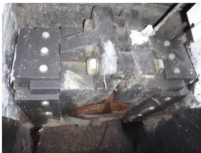
Figure 7 – Butée transversale en rive droite
