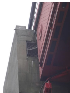
Figure 8 – Ancrage longitudinal en rive gauche
